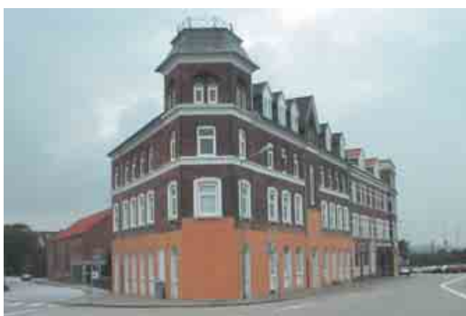
Østergade 54 - opført i 1899 som jernbanehotel i historicistisk stil med flittig brug af pudsdekorationer som vinduesindfatninger, sølbænke og gesimser.
