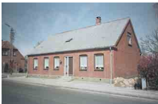
Østre Hovedgade 37, Hjerm - opført 1910. Velproportioneret længehus med god rytme og facadehøjde. Murværksdetaljer som hovedgesims samt vindues- og dørindfatninger.
