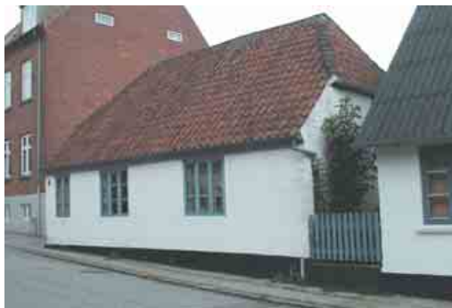
Bjerggade 20 - Et ældre traditionelt gadehus med lav facadehøjde og halvvalmet tag, der har erstattet et tidligere stråtag. Huset er formodentlig et tidligere fiskerhus.
