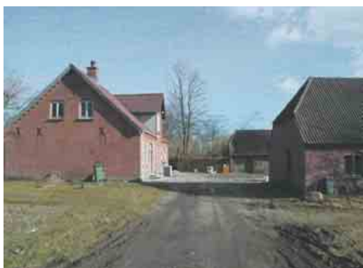
Firlænget gårdanlæg, Kviumvej 8 - opført i 1917. Et intakt gårdanlæg, der er med til at tegne bymiljøet langs det slyngede vejforløb.
