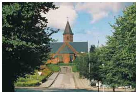
Struer Kirke fremtræder monumentalt med sin placering på et bakkeplan i byen.
