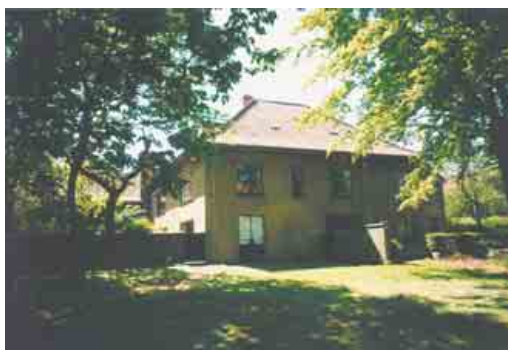
„Det gule hus“, Nørgårdsvej 4 - opført 1936. Huset er et af de mest markante blandt flere funkishuse i kvarteret omkring B&O. Huset har funktionalismens karakteristiske pudsede facader, og stålrammedøre og -vinduer.
