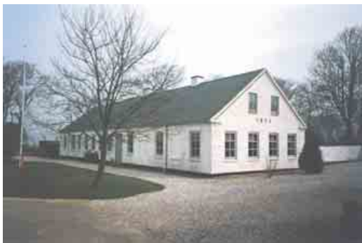
Tidligere Øster Hjerm Gl. Skole, Kviumvej 14 - opført 1897. Eksempel på de ældre 1. generations skolebygninger opført som traditionelt længehus med klasseværelse og lærerbolig i hver sin ende af bygningen.
