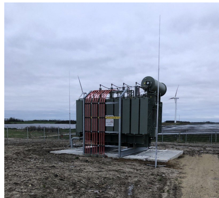
Eksempel på 60/20 kV power transformer.
