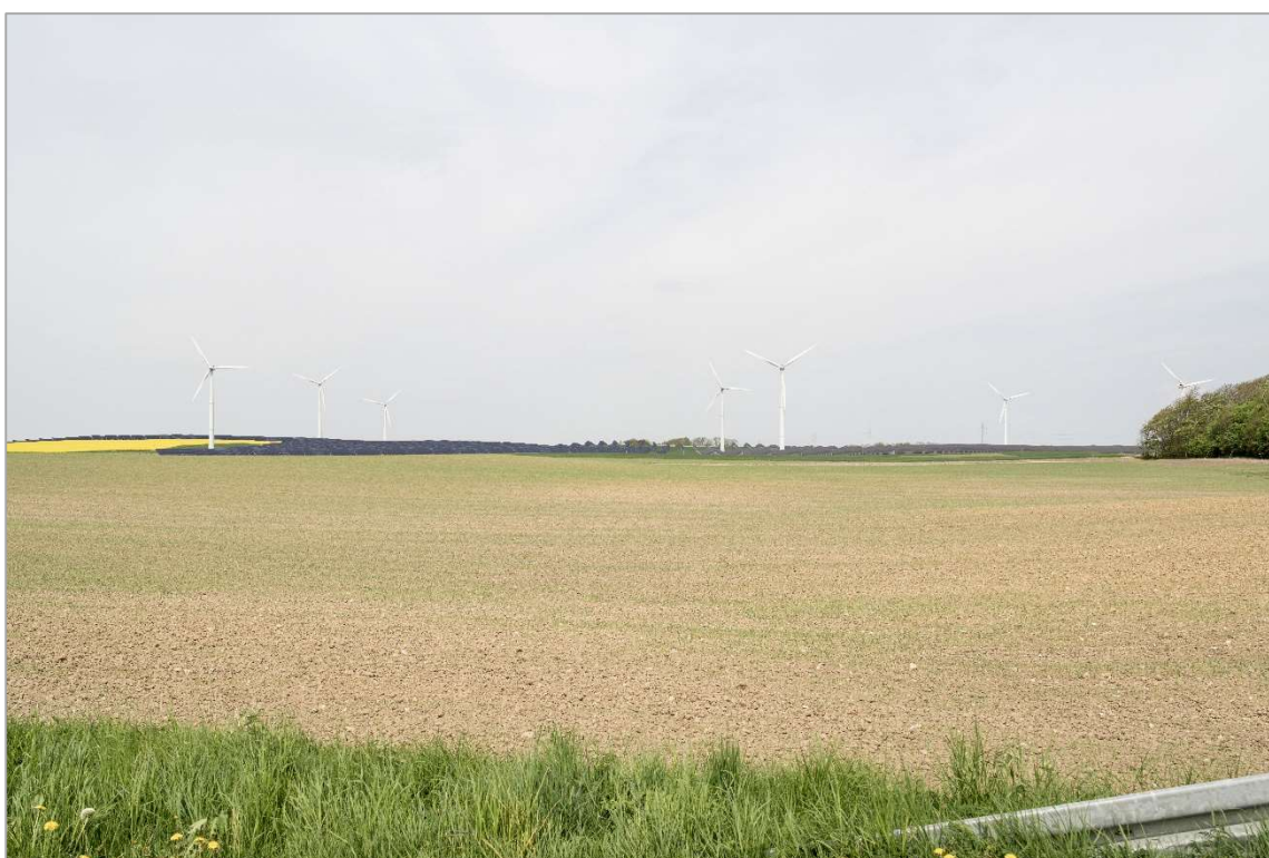
Udsyn med solceller opsat
