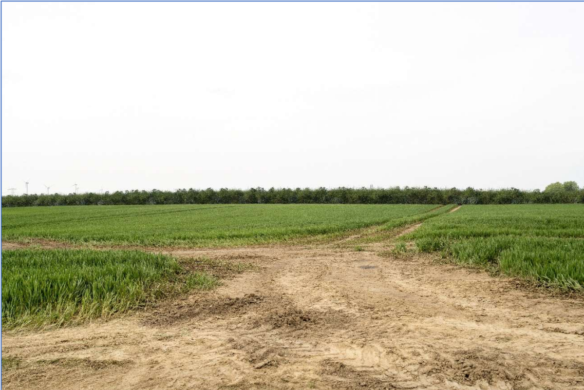
Udsyn med solceller opsat, dækket af læhegn
