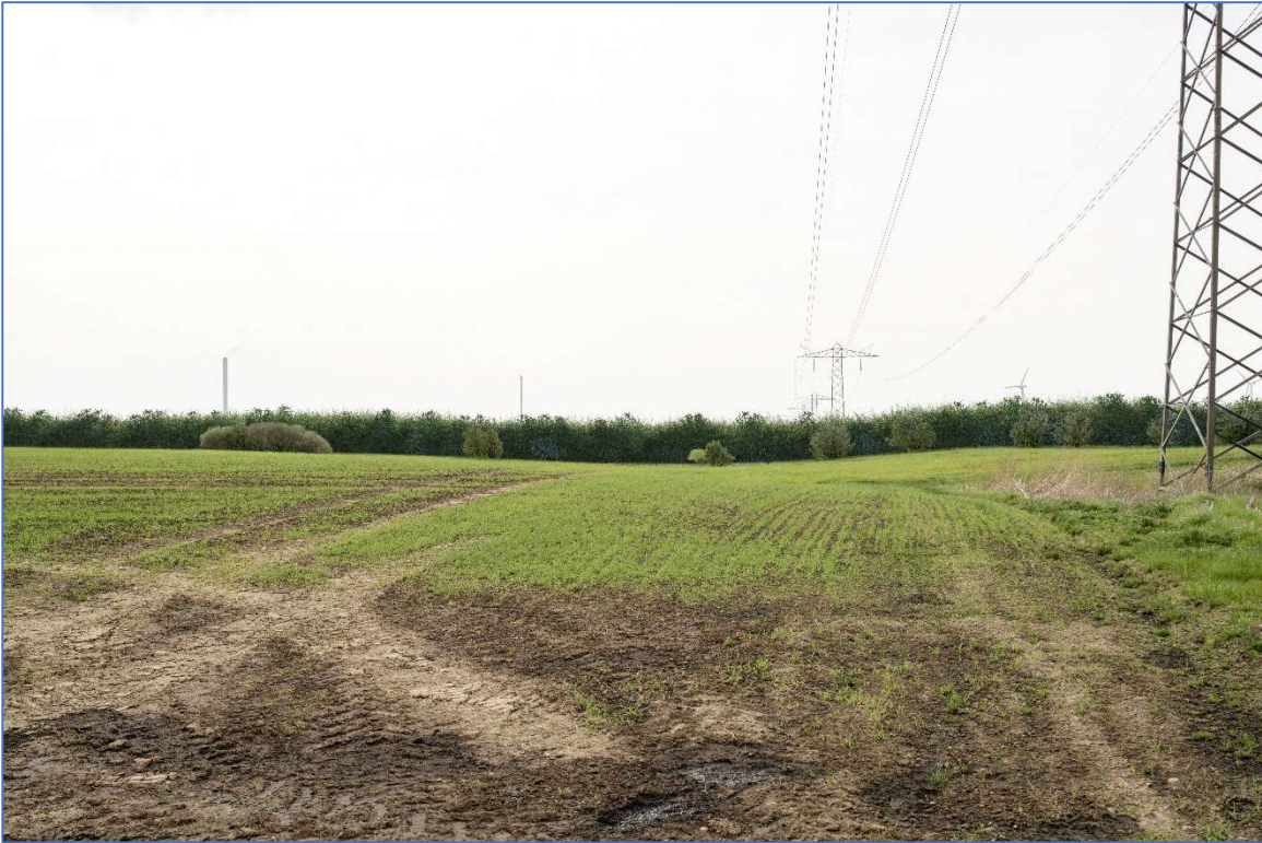
Udsyn med solceller opsat, dækket af læhegn
