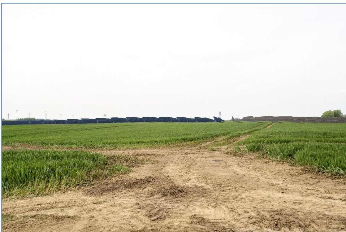
Udsyn med solceller opsat
