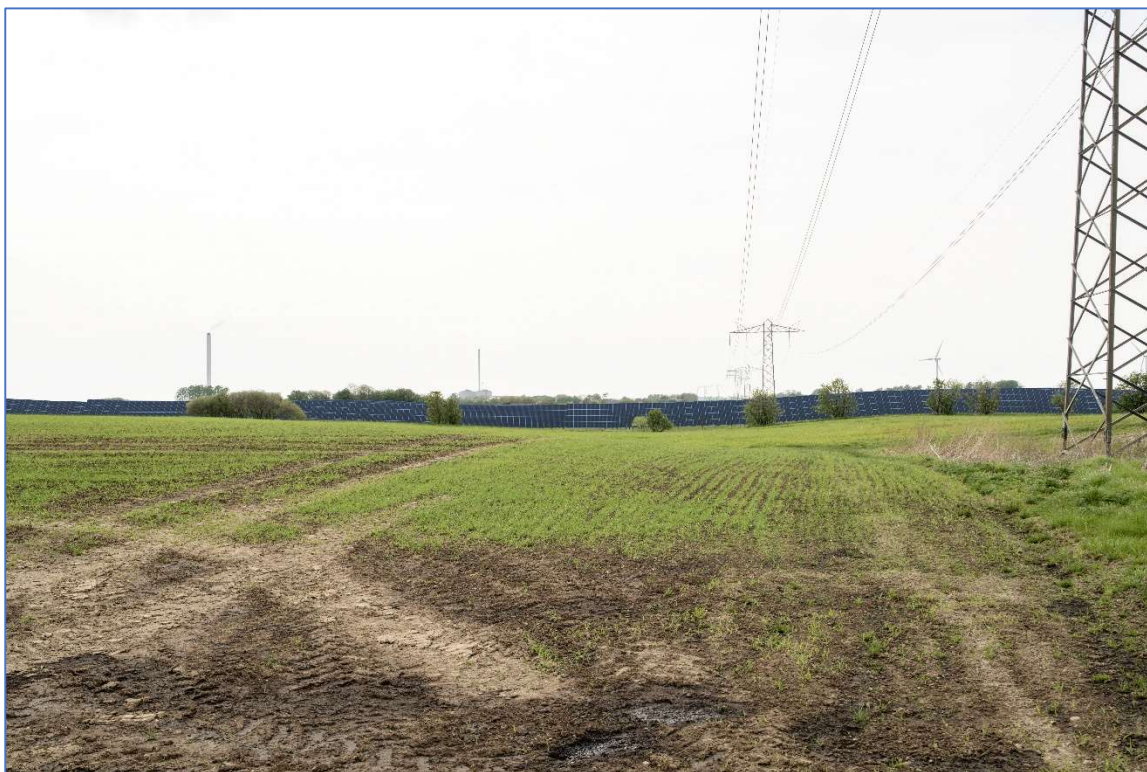
Udsyn med solceller opsat
